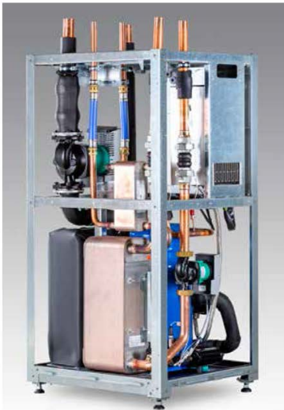
Obr. 5: Tepelné čerpadlo Mega, konfigurácia jeho dielov a umiestnenie výmenníku prehriatych pár pre prípravu TV počas vykurovania.
