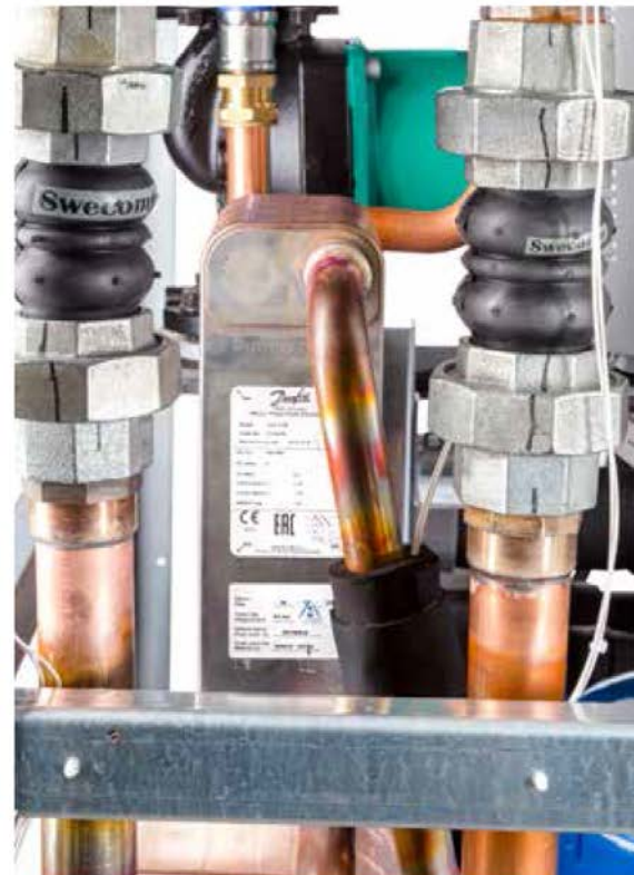
Obr. 5: Tepelné čerpadlo Mega, konfigurácia jeho dielov a umiestnenie výmenníku prehriatych pár pre prípravu TV počas vykurovania.
