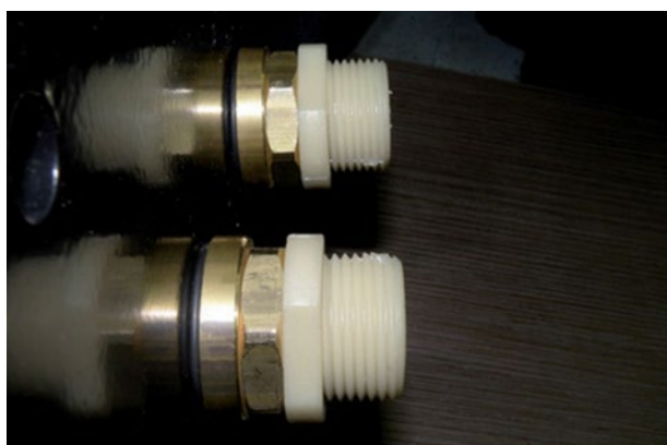
Izolačné oddelenie medenej vykurovacej vložky od prívodného a vratného potrubia
