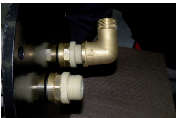
Izolačné oddelenie medenej vykurovacej vložky od prívodného a vratného potrubia
