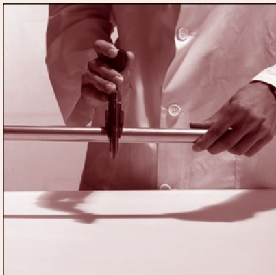
Obr. 21 Řezání trubky Rezanie potrubia
